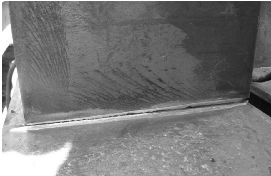
سرتاسر عدم نفوذ جوش در ریشه اتصال
