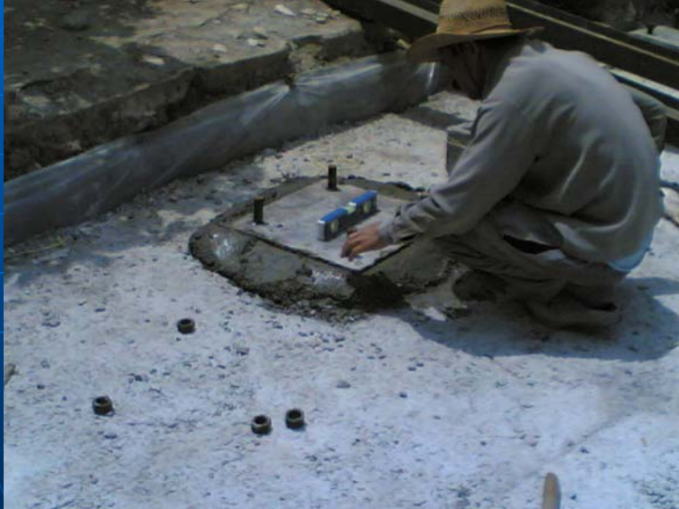
رگلاژ نهائی کف ستون
