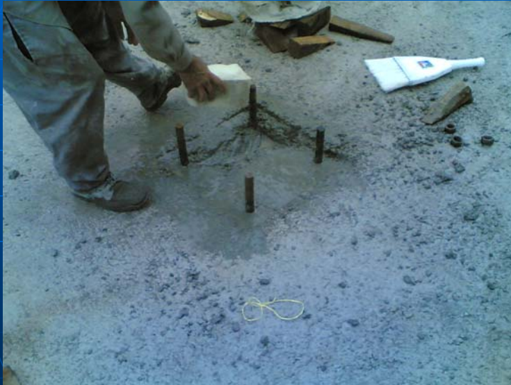
آماده سازی جهت اجرای مالمیچه زیر کف ستون گروه عمران دانشگاه گیلان- جواد رزاقی
