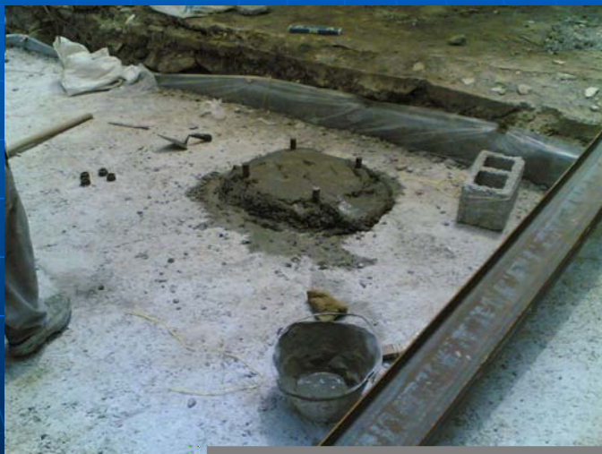
اجرای مالمیچه بتنی زیر کف ستون
