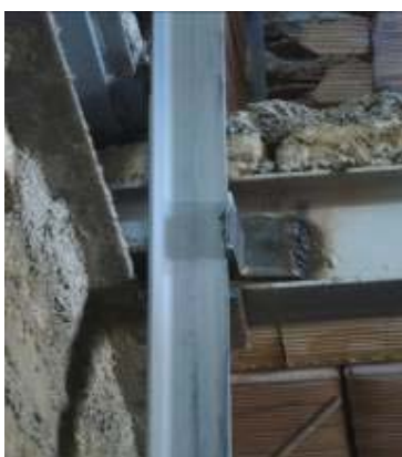
اتصال دو تیر آهن به هم
