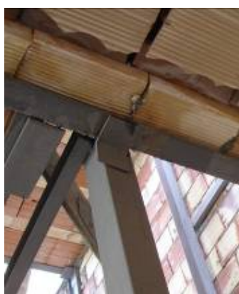
اتصال کلاف افقی به تیر آهن اطراف چاه
