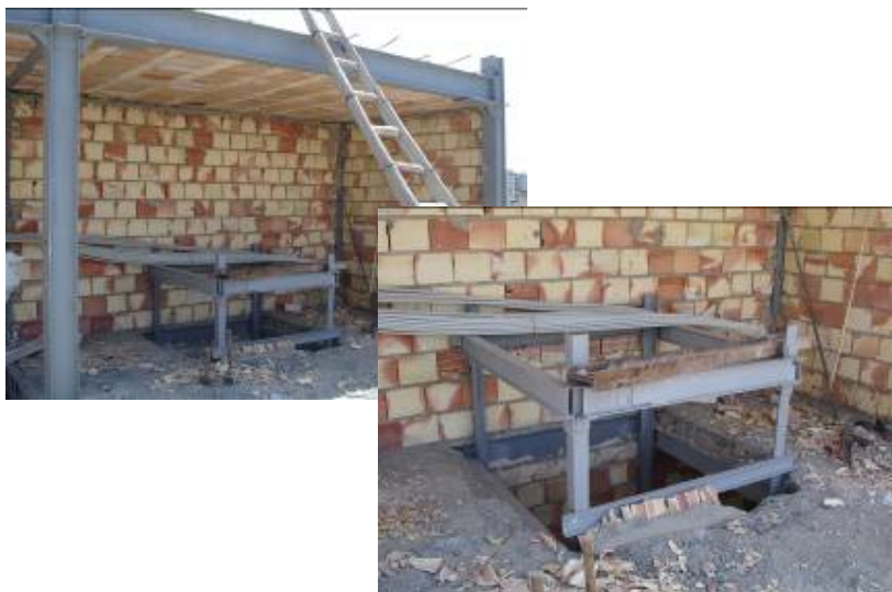
موتورخانه و اتصالات تیر آهن سقف چاهک
