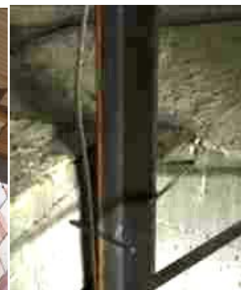
اتصال کلاف افقی به تیر آهن اطراف چاه
