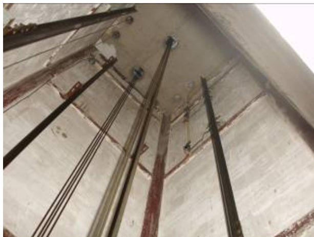
سقف چاهک پس از بتون ریزی
