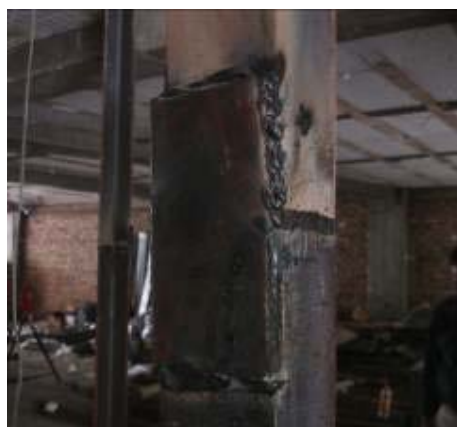
اتصال دو تیر آهن به هم
