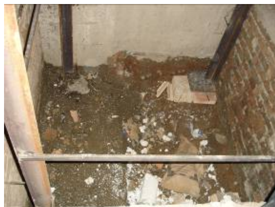
چاهک آسانسور قبل از بتون ریزی
