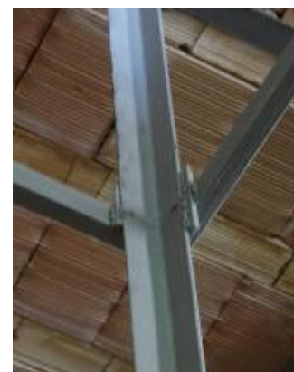
اتصال کلاف افقی به تیر آهن اطراف چاه
