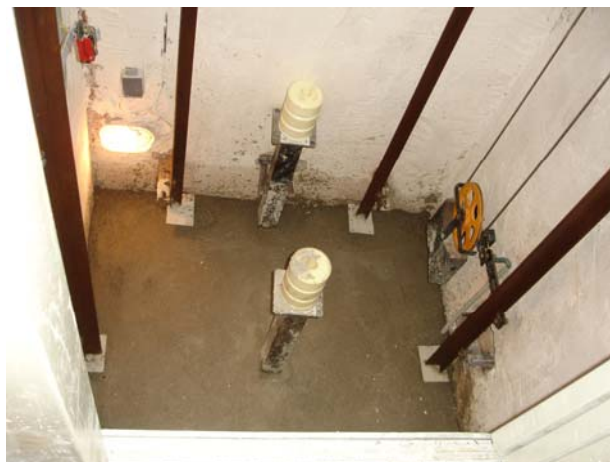
کف چاهک پس از بتون ریزی
