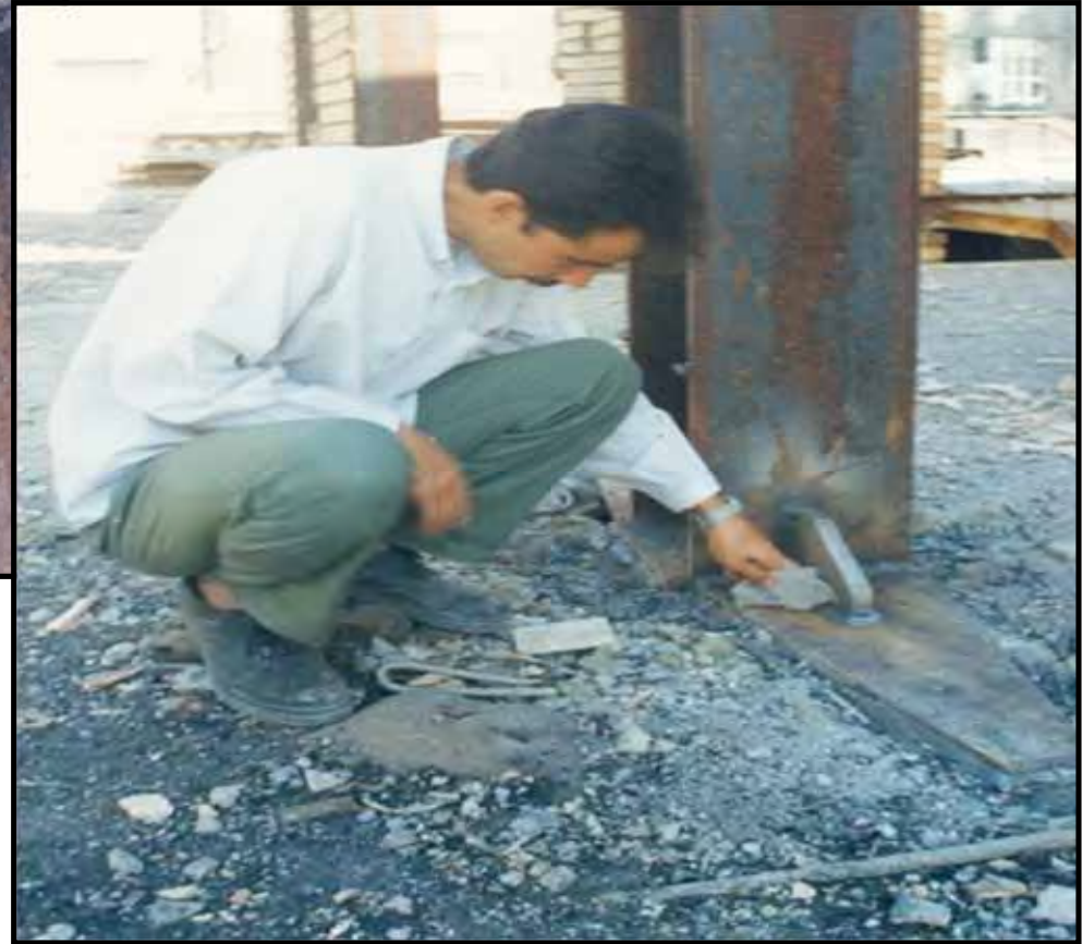
بازرس جوش در حال اندازه گیری ابعاد جوش
