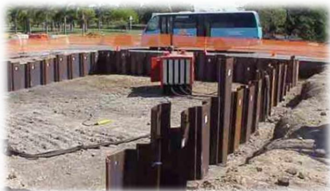
شکل (۸-۲) روش سپر کوبی
