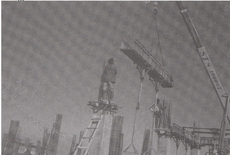
شکل (۳-۲۷) قالب یکپارچه تیر در حال پرواز
