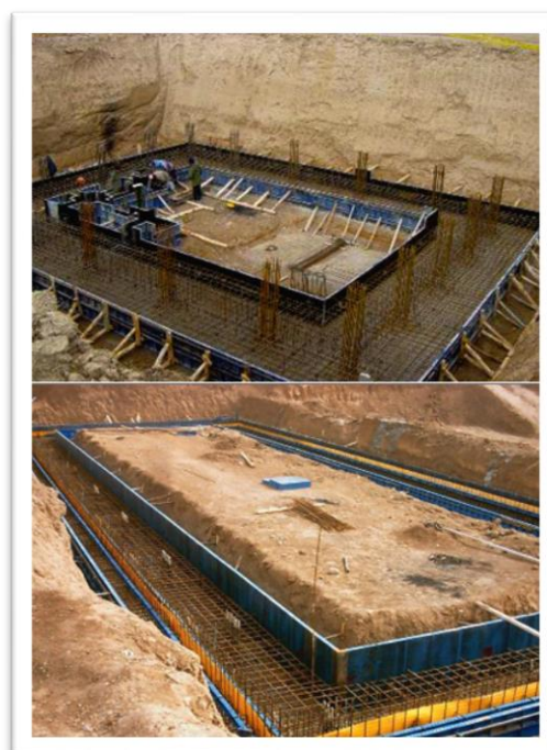
شکل (۲-۲۷) قالب فلزی فونداسیون
