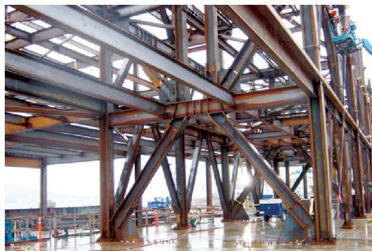
انواع قابهای مهاربندی برون محور (واگرا) EBF
